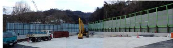
掘削岩石仮置場（遮水構造）及び仮囲い（防じん・防音構造）
